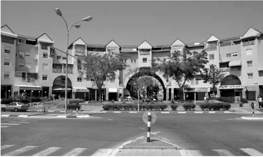
איור 8ב: תמונה של הכניסה למדרחוב, שם
