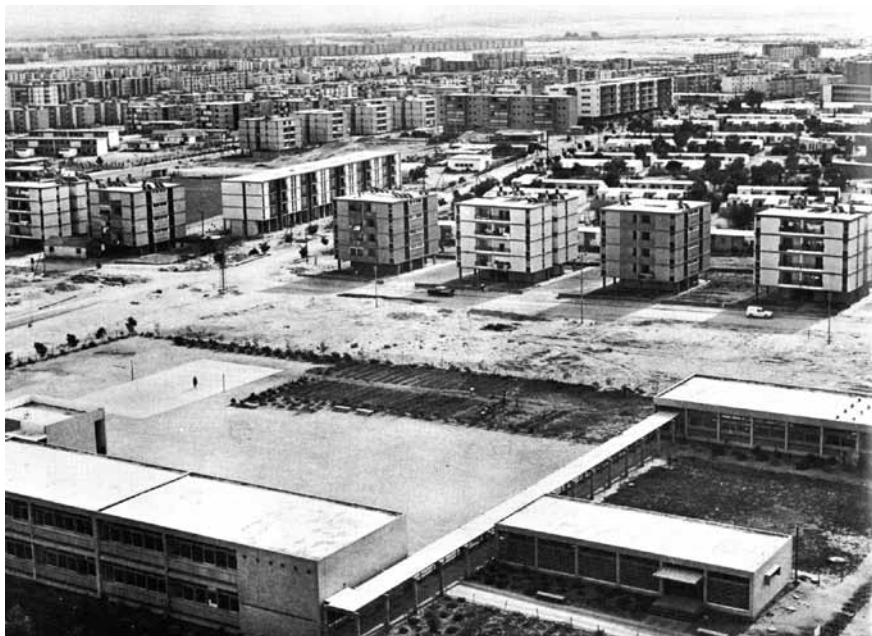
איור 2: ציפוף ובתים גבוהים יותר. מבנים סטנדרטיים ארוכים ומרובעים שאיפיינו את בניית משרד השיכון בשנות השישים. מתוך: משרד השיכון, 'שיכון וקליטת עולים', ישראל בונה 1964, מדינת ישראל, משרד השיכון, האגף לתכנון והנדסה, [תל אביב] 1964
