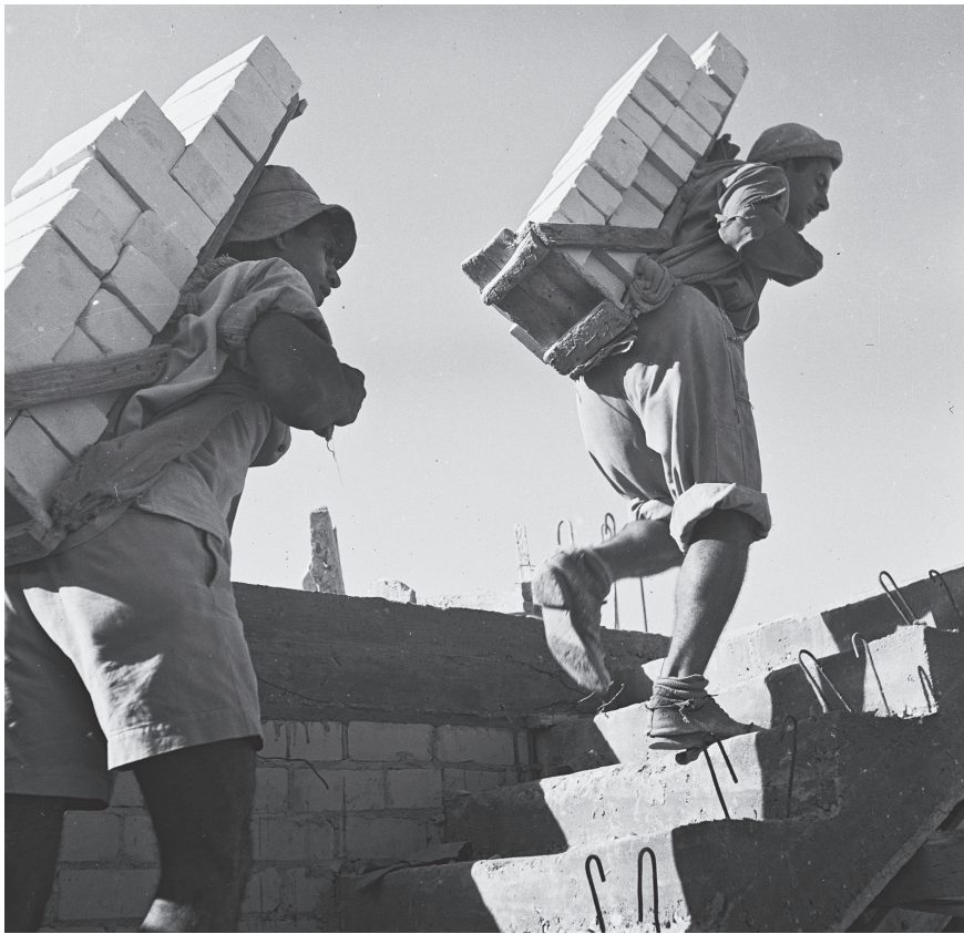
תצלום 7: פועלים נושאים לבני סיליקט באתר בנייה בתל אביב, 1946 צלם: זולטן קלוגר, אוסף התצלומים הלאומי
