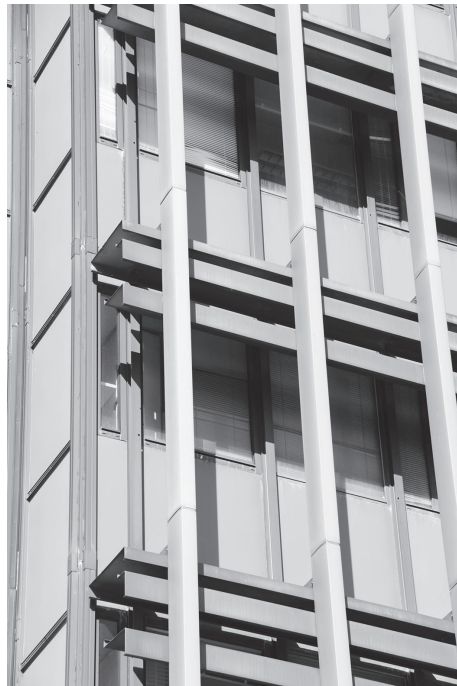
תצלום 15: שוברי שמש מאלומיניום בקיר המסך במגדל אשכול באוניברסיטת חיפה בתכנון אוסקר נימאייר ושלמה גלעד, נחנך ב־1977 צלם: אור אלכסנדרוביץ', 2013
