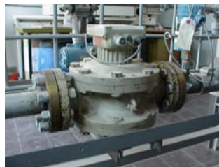
איור 3 : מד ספיקה Positive displacement.
